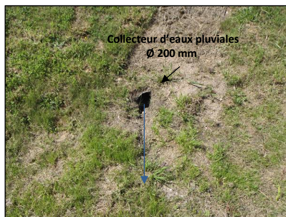
Rejet d'eaux pluviales alimentant l'ouvrage de rétention
