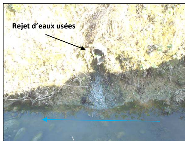
Rejet d'eaux usées au droit du fossé du hameau « Terre Masse »
