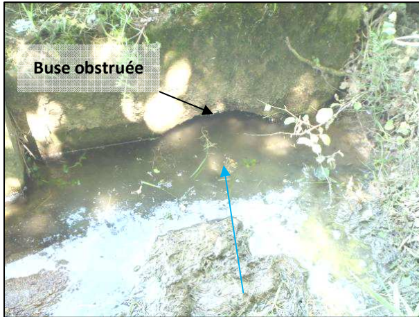
Obstruction de la buse \varnothing 500 mm au droit du hameau « Chez Janisson »
