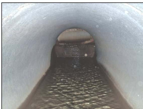
Ouvrage de rétention – Ø 1 000 mm
