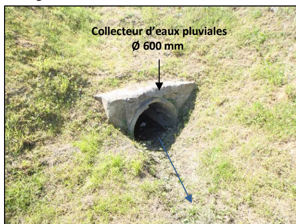
Rejet d'eaux pluviales alimentant l'ouvrage de rétention
