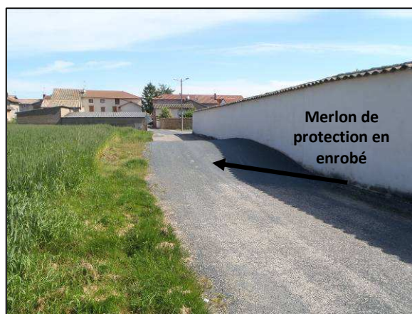
Protection contre le ruissellement chemin des saulaies
