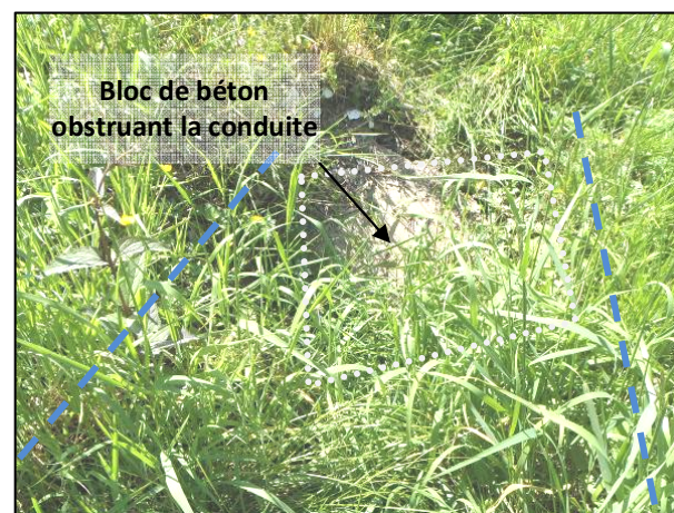
Obstruction de la buse Ø 300 mm au droit du hameau « Au Ripel »
