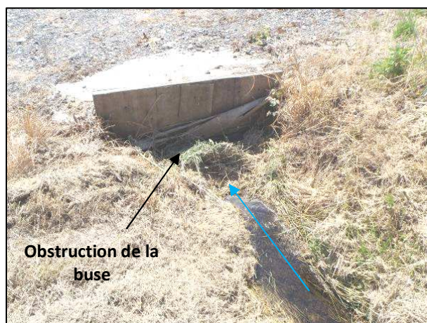
Obstruction de la buse Ø 300 mm au droit du hameau « Cheval blanc »
