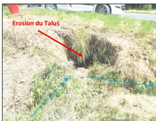
Erosion du fossé au droit de la route de Baneins
