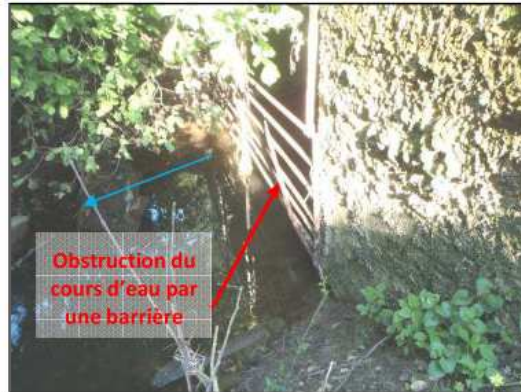
Ouvrage de franchissement du Moignans au droit du hameau « Terre masse »
