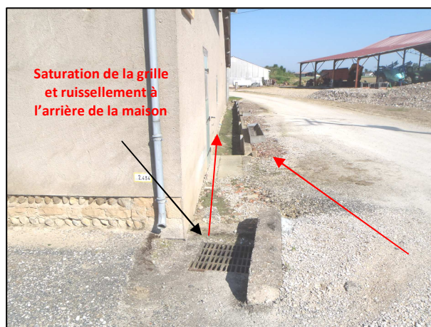
Habitation inondée au droit du hameau « Le Prunier »
