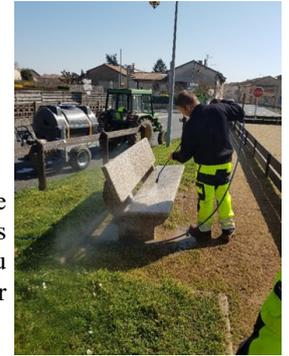
Ils ont également entrepris le nettoyage du mobilier urbain et des trottoirs, grâce au nouveau tonneau d'arrosage, sur lequel un nettoyeur haute pression peut être branché.
